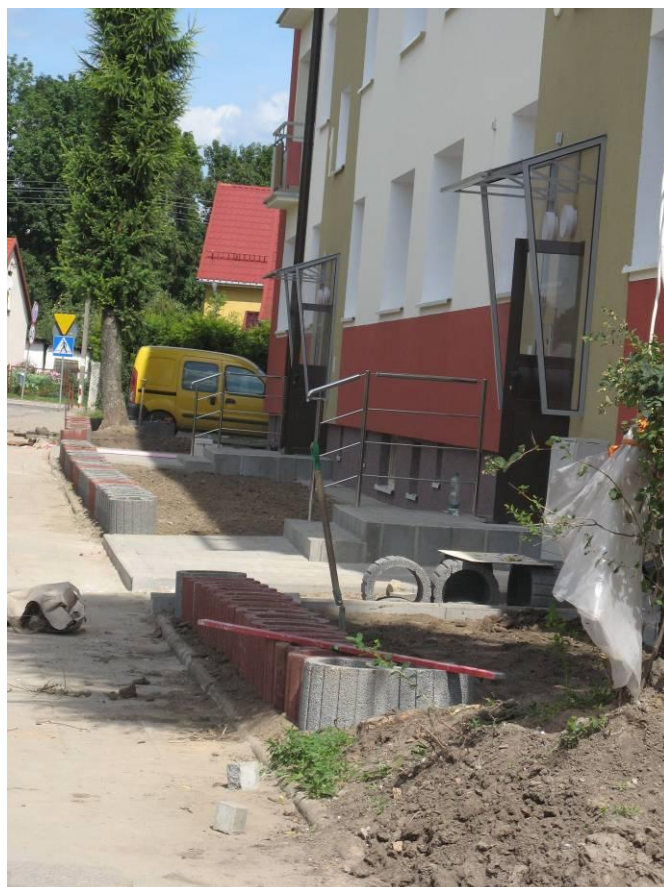
Fot.8. Zagospodarowanie terenu
