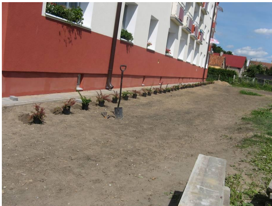
Fot.7. Zagospodarowanie terenu
