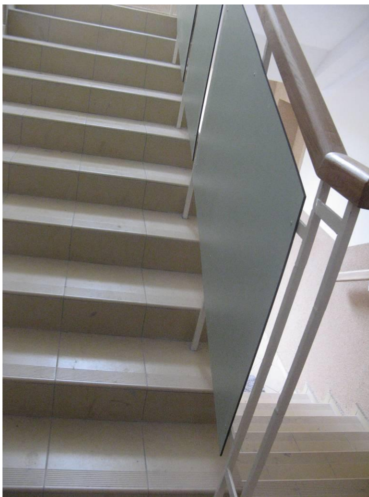
Fot.10. Montaż płyt na klatkach schodowych
