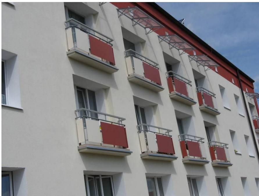
Fot.11 Montaż płyt balkonowych
